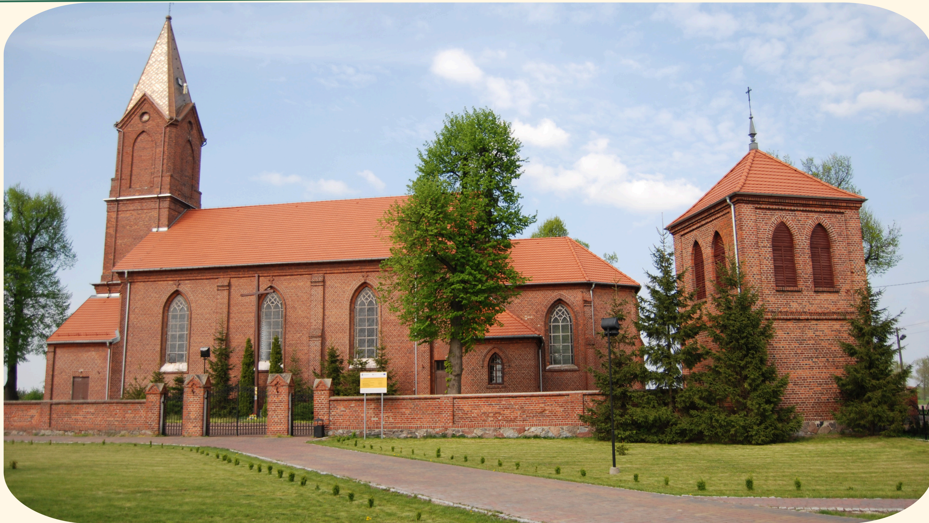
KOŚCIÓŁ MUROWANY NEOGOTYCKI Z 1881 R. P.W. ŚWIĘTEJ TRÓJCY Z DZWONNICĄ W KŁOTNIE
